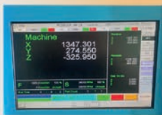
Sistema de Control Sofisticado
